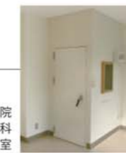
某病院 耳鼻咽喉科 検査室
